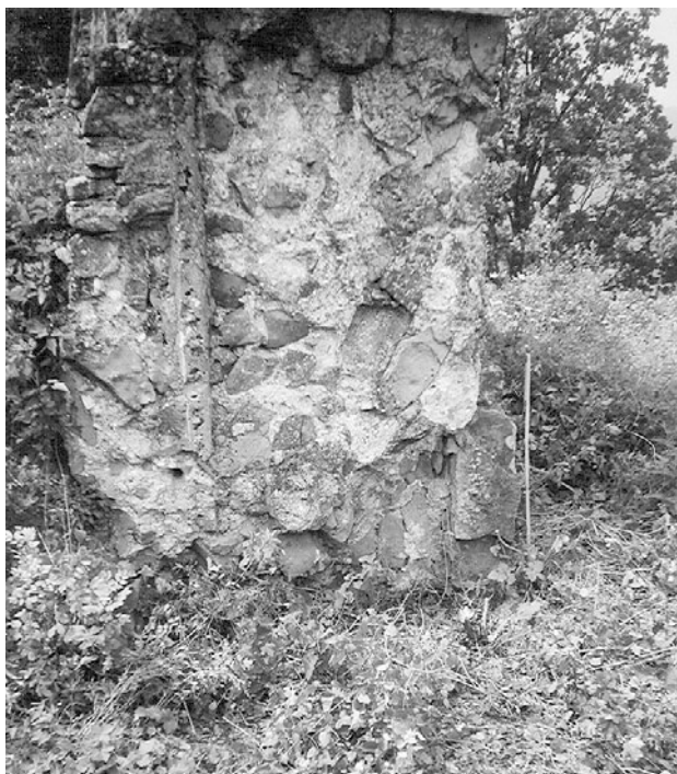
Fig. 9 – Cosseria. Parte del troncone di torre abbattuto; in basso a destra si nota il taglio (1), che doveva essere stato eseguito all'angolo della torre.
