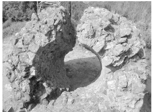
Fig. 14 – Particolare dell’area di scalzo sui resti del troncone della torre della Brina.
