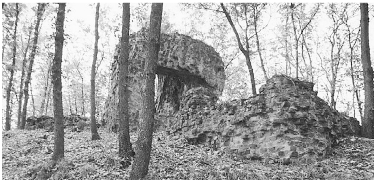
Fig. 11 – Vista d’insieme della base in pietra (in primo piano) e del blocco abbattuto (in secondo piano) della torre del Marocco. Nell’immagine si possono notare gli elementi litici originariamente appartenenti al basamento in pietra, ancora attaccati al troncone abbattuto.
