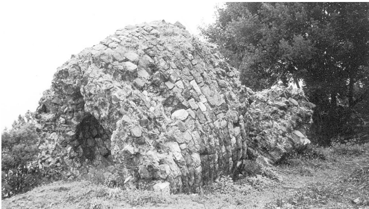
Fig. 1 – Il moncone della torre della Brina risultato dall'operazione di abbattimento.
