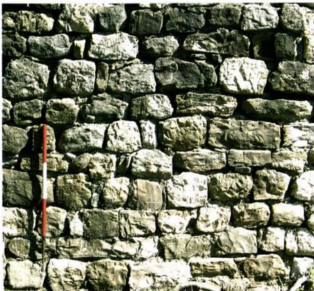
Fig. 26. Particolare della cinta del cassero in bozze di calcare e arenaria (XIII secolo)
