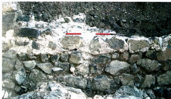
Fig. 25. La tecnica muraria in pietra locale risalente all'XI-XII secolo
