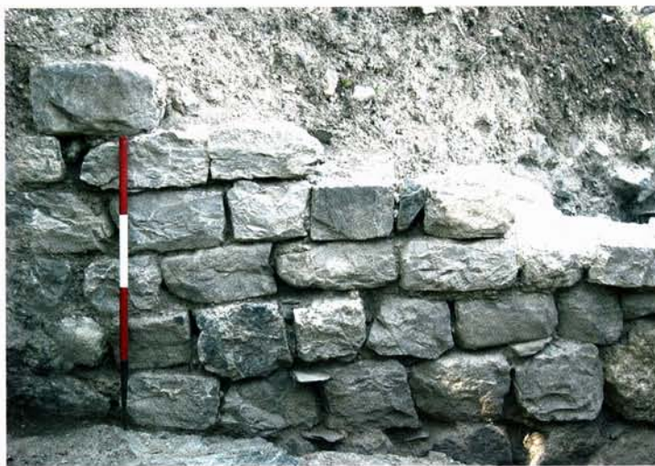
Fig. 24. Particolare della tessitura muraria del primo impianto fortificato
